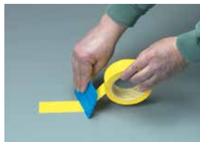
Нанесение ленты с использованием ракеля
